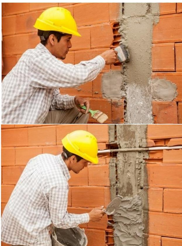
*Aplicación de promotor de adherencia y revoque termoaislante sobre estructura de HºAº.*
