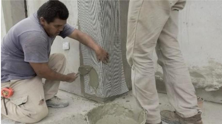
*Aplicación de basecoat sobre revoque termoaislante.*
