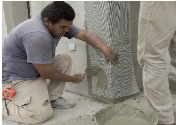
*Aplicación de basecoat sobre revoque termoaislante.*
