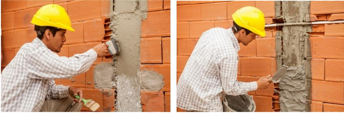
*Aplicación de promotor de adherencia y revoque termoaislante sobre estructura de H°A°.*
