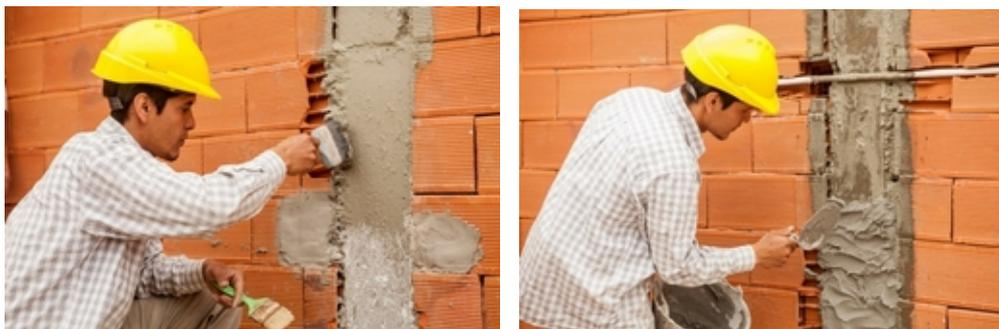
*Aplicación de promotor de adherencia y revoque termoaislante sobre estructura de HºAº.*
