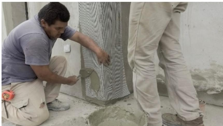
*Aplicación de basecoat sobre revoque termoaislante.*
