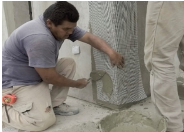
Aplicación de basecoat sobre revoque termoaislante.
