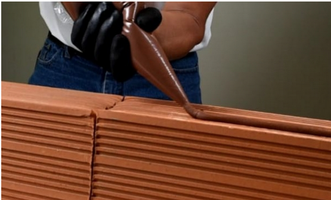
Aplicación de mortero en manga.
